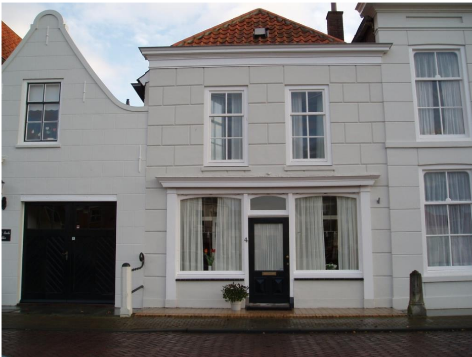
Haven ZZ. 4, te Brouwershaven
