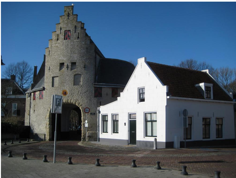
Scheepstimmerdijk 1, Zierikzee. Het huisje aan de Noordhavenpoort.
